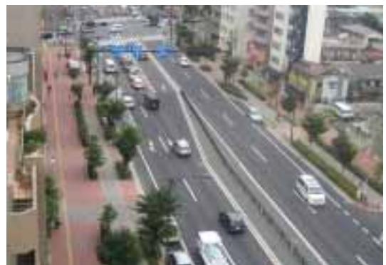
拡幅完成した山手通り(上方が早稲田通り)
